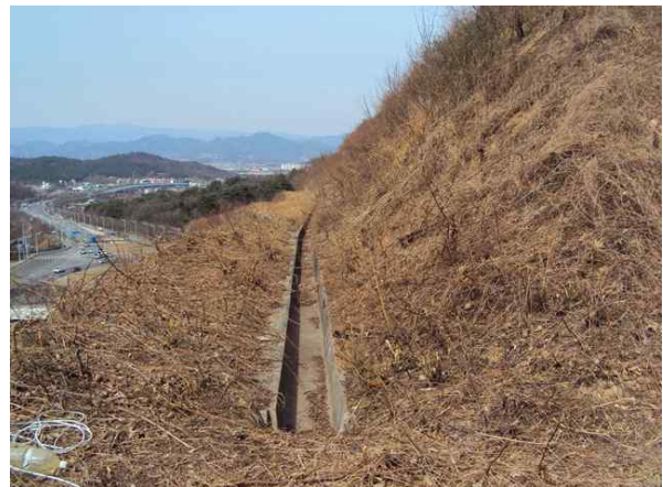
2소단 배수로 전경
