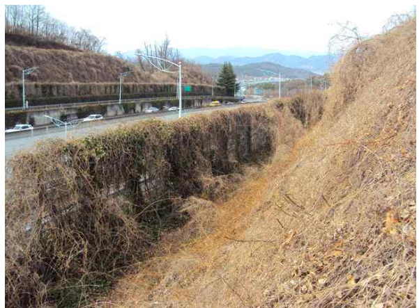
낙석방지울타리 및 하부 전경
