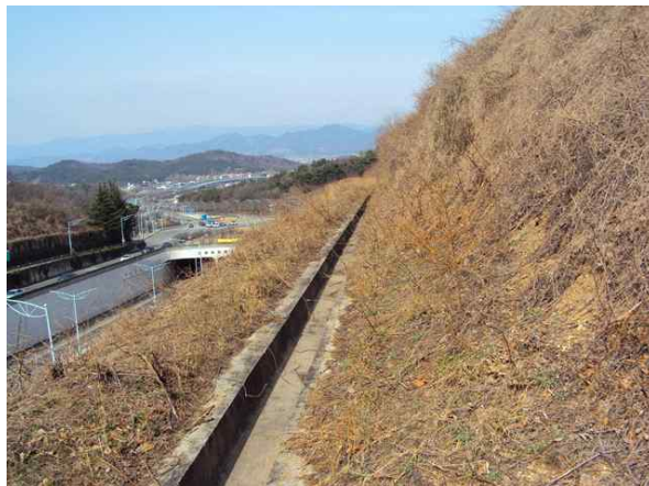
1소단 배수로 전경
