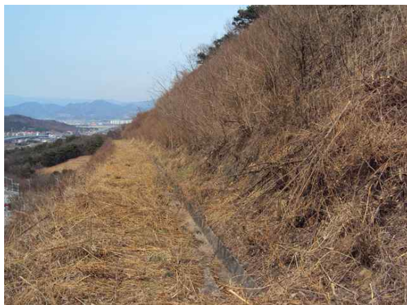
3소단 배수로 전경
